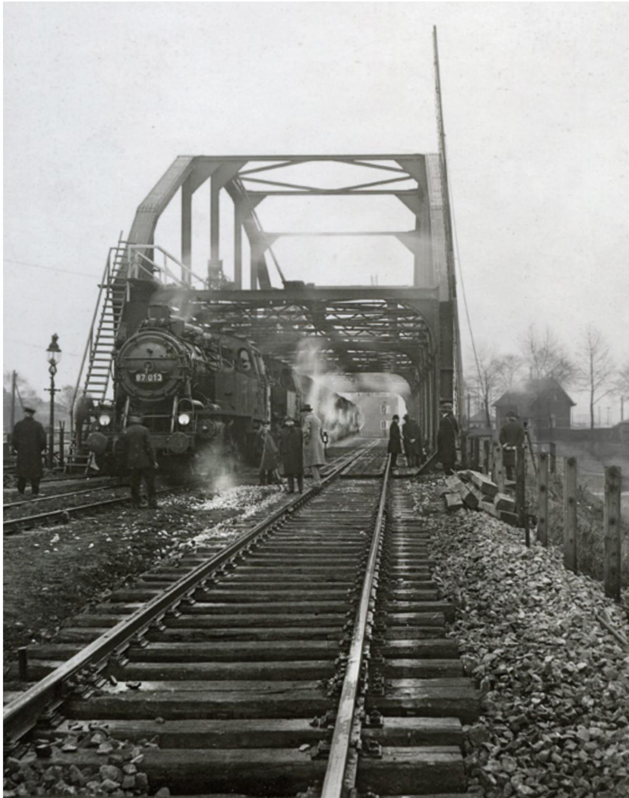
Für die Belastungsprobe der Reiherstiegbrücke wurden die acht Lokomotiven der Baureihe 87 auch als Lokzug zusammengestellt, was einem Gesamtgewicht von 684,8 t entsprach. Angeführt wird der Lokzug von der 87 013.
